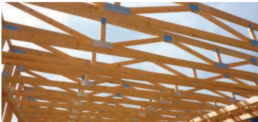
Detail spojů nosné konstrukce vybraných domů Atria
